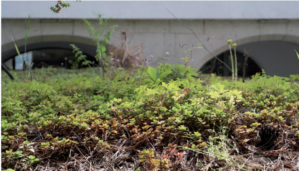
Beispiel für einen bepflanzten Dachbereich.
